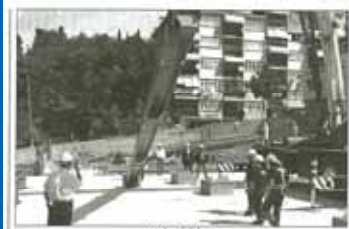
KOLON BAŞLIYOR Okulun inşaatı için kolonlar betonla dolduruldu. (Seyhan Gazetesi)
