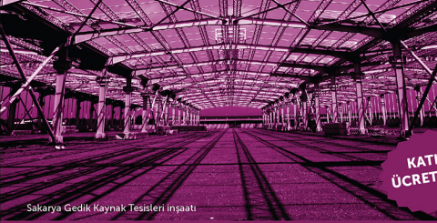
Sakarya Gedik Kaynak Tesisleri inşaatı
