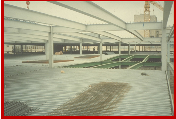
Şekil 9. Ters sehim verilmiş kompozit döşeme kirişleri.
