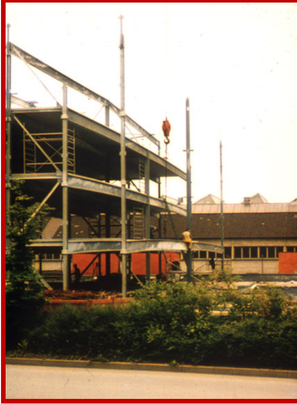
Şekil 9. Ters sehim verilmiş kompozit döşeme kirişleri.
